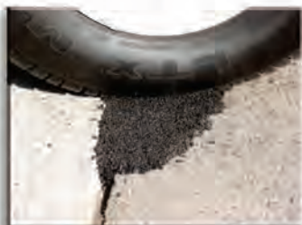
碾压或夯实，即可开放交通，施工方便快捷。
