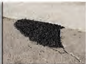
冷铺料应覆盖修补区域以外5厘米。
