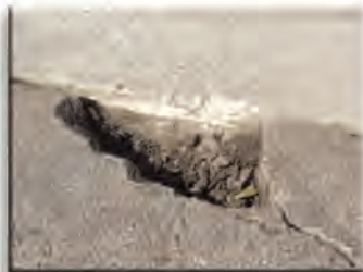
清扫坑洞中松散石屑，将冷补料倒入
